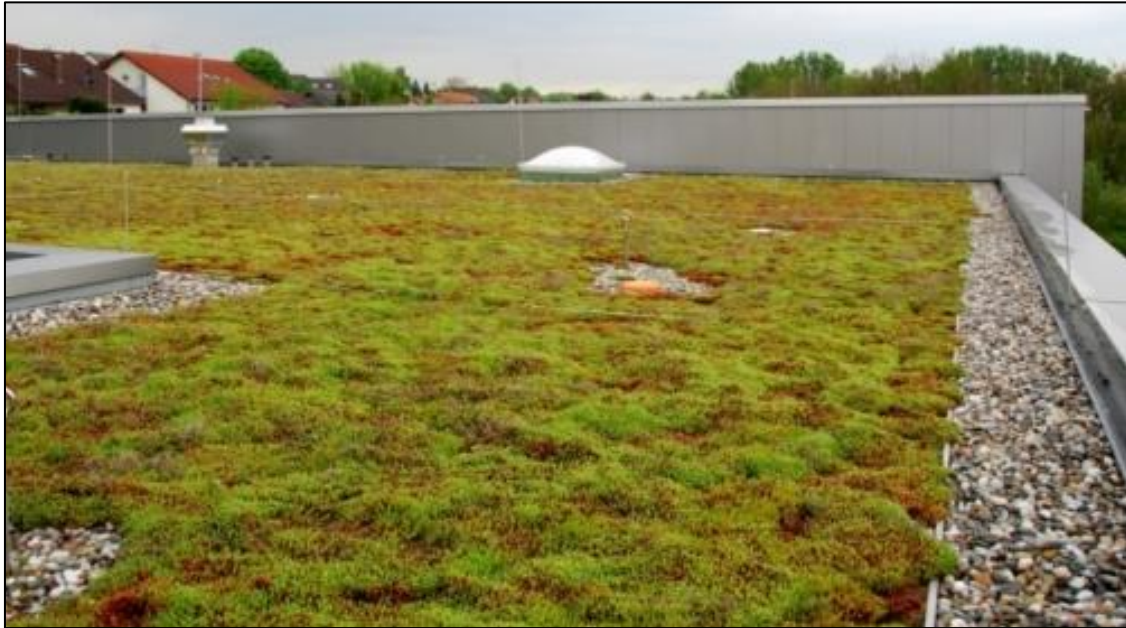
Kuva 10. Esimerkki helppohoitoisesta maksaruohoviherkatoista. Kuva Envire Oy.
